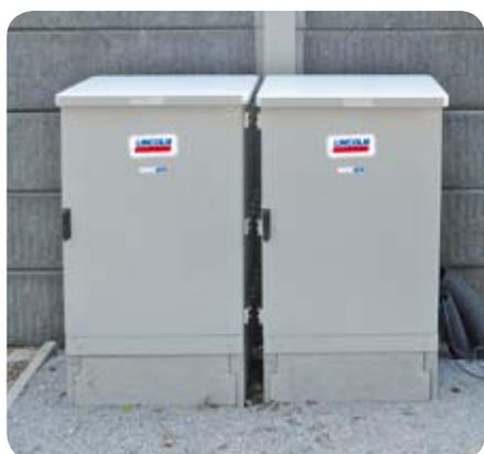
*Внешний шкаф для насоса 800 x 500 x 1200 мм с подходящим бетонным основанием*
